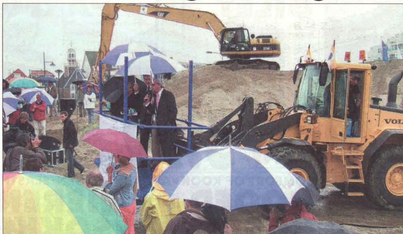
Bulldozers, paraplu's, vip's: het is woensdag 5 september allemaal te zien op het strand. (foto pr; www.actief-in-noordwijk.nl )
