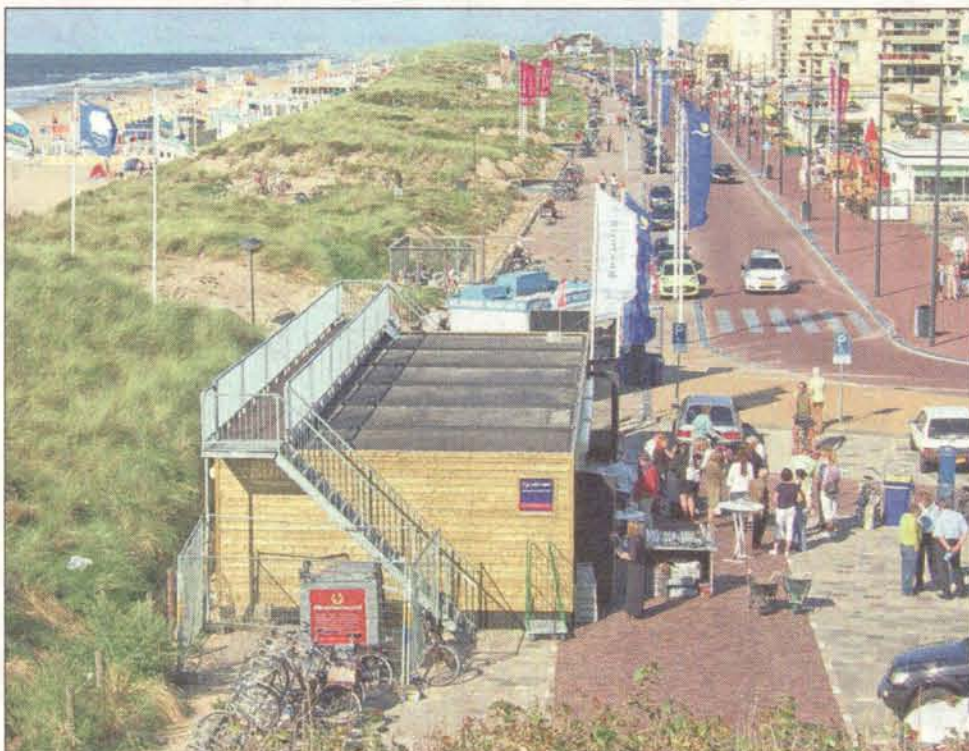
Het informatiecentrum staat op de hoek Palaceplein/Koningin Wilhelminaboulevard. (foto: pr)
